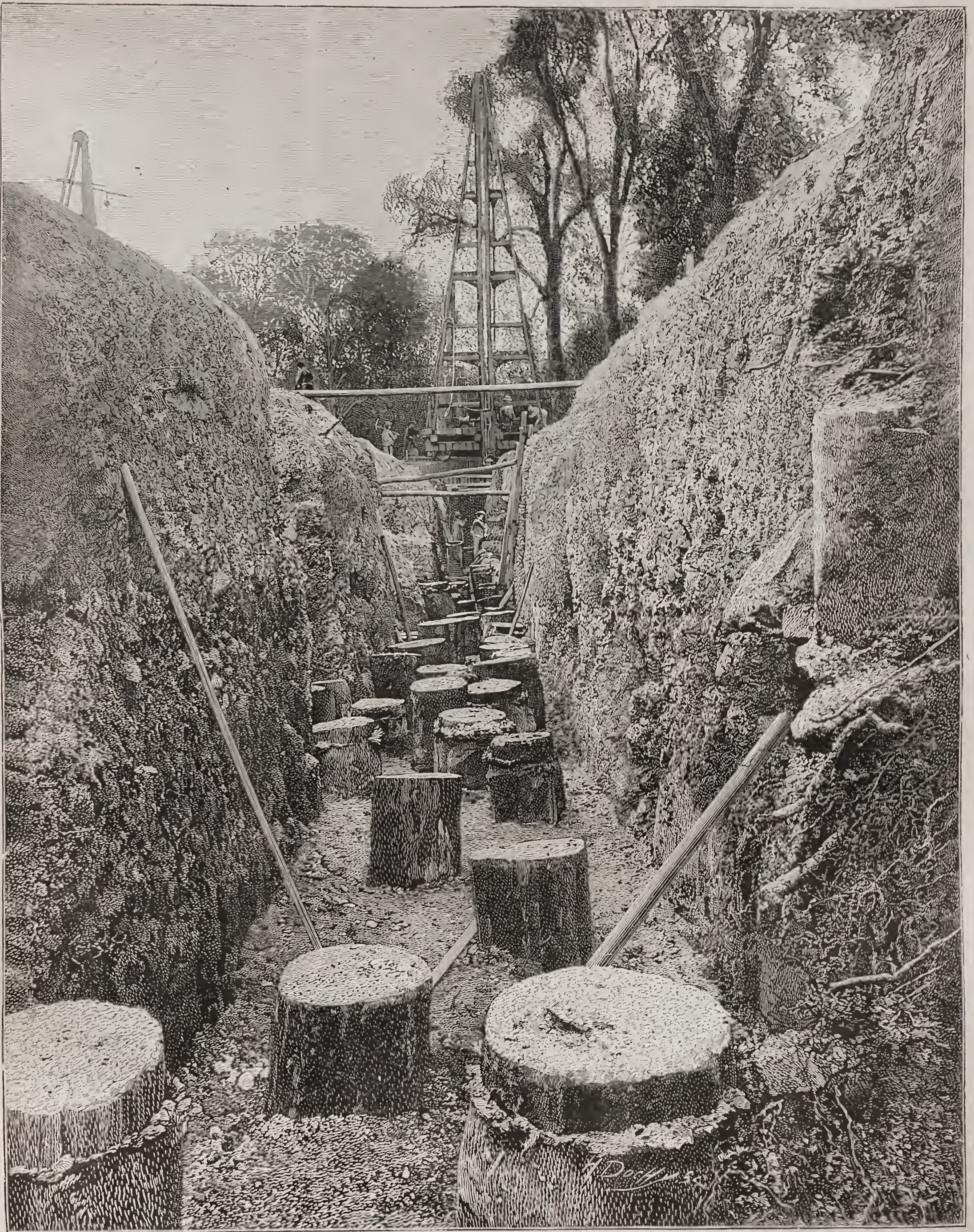
LES CHANTIERS DES CHAMP-ÉLYSÉES : — Les pilots du Grand Palais.
